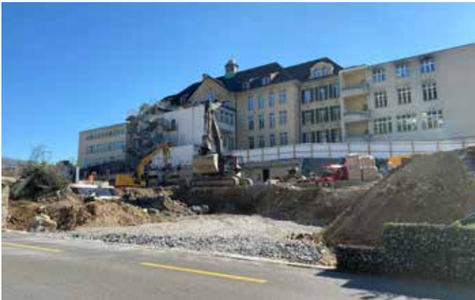
Baustellenzufahrt via Scharthenstrasse
