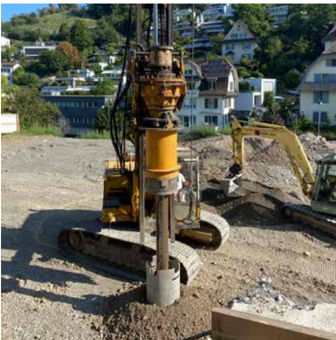
Auch an der Nordseite des «Palace» werden die Vorbereitungen für die Rühlwände getroffen.
