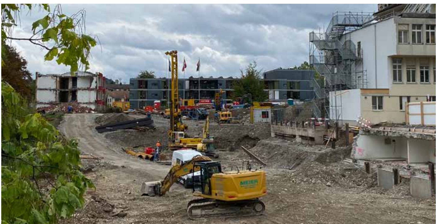
Die Baustelle wächst von Tag zu Tag
