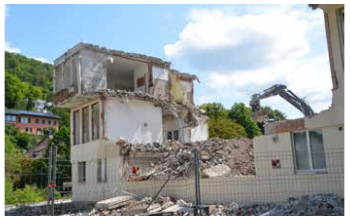
Rückbau «Palace»-Anbau Nord
