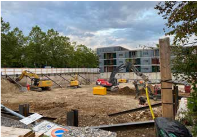
Hier entsteht die neue Tiefgarage.
