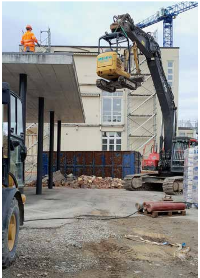
Rückbau Verbindungsgang
